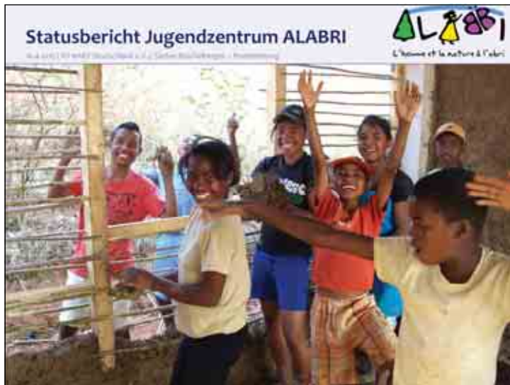
Aufgebaut wurde unser Wohnheim in einfachster Lehmbauweise durch gemeinsame Anstrengung von Schülern, Eltern, Ehemaligen und Mitarbeitern.
